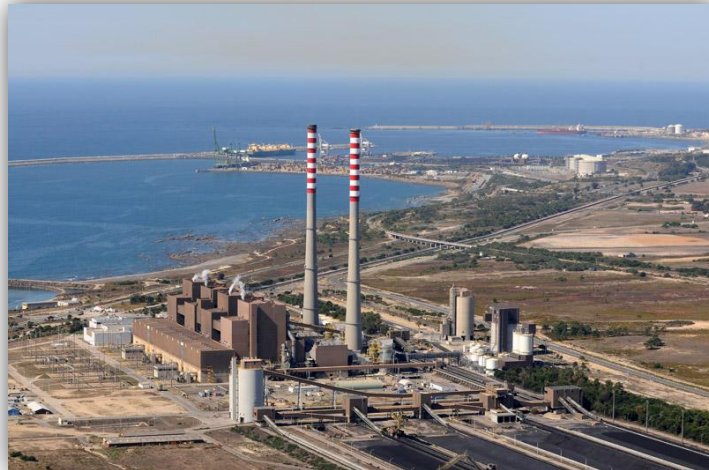
Figura 26 - Central Termoelétrica de Sines
