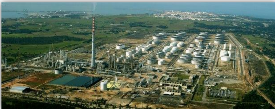
Figura 27 - Refinaria de Sines
